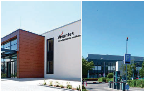
Οι εγκαταστάσεις των Εξωτερικών Ιατρείων του Humboldt στο Βερολίνο
