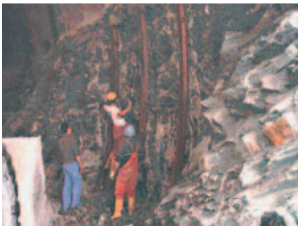
Εικ. 12. Τοποθέτηση οπλισμένων δοκών. Πηγή: Μελέτη για τα Τεχνικά Έργα του ΕΛ.ΙΝ.Υ.Α.Ε. Φωτογραφία: Κ. Λώμη.
