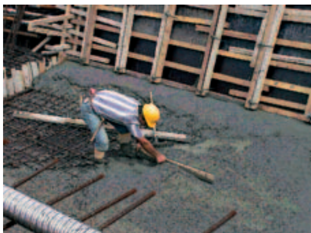
Εικ. 6. Σκυροδέτηση γέφυρας. Διάστρωση.
