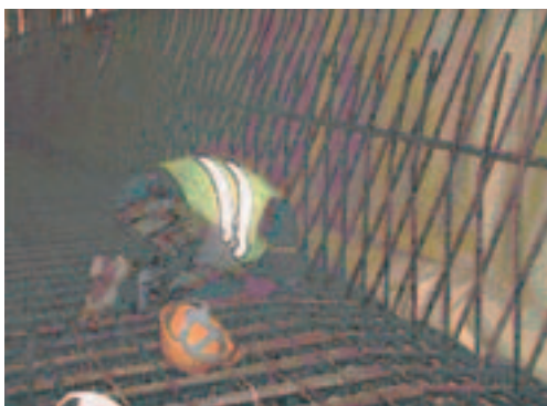
Εικ. 15. Σιδερώμα θόλου σήραγγας.
