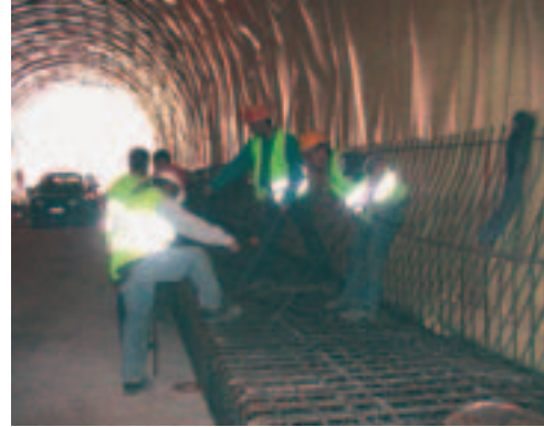
Εικ. 11. Τοποθέτηση οπλισμού με χρήση διχάλας. Πηγή: Μελέτη για τα Τεχνικά Έργα του ΕΛ.ΙΝ.Υ.Α.Ε. Φωτογραφία: Κ. Λώμη.
