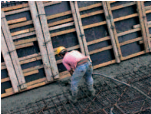
Εικ. 18. Σκυροδέτηση γέφυρας Χρήση δονητών για το στρώσιμο του τοιμέντου.
