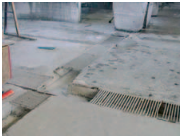
Σχήμα 2: Δάπεδο με ακατάλληλα καλύμματα καναλιών
