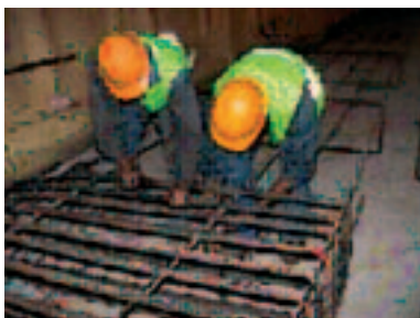
Εικ. 4. Τοποθέτηση οπλισμού
