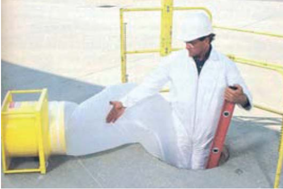
Εικόνα 28: Εισαγωγή αέρα με κατάλληλο εξοπλισμό ώστε να μην εμποδίζεται η ασφαλής πρόσβαση ή έξοδος του εργαζόμενου.
