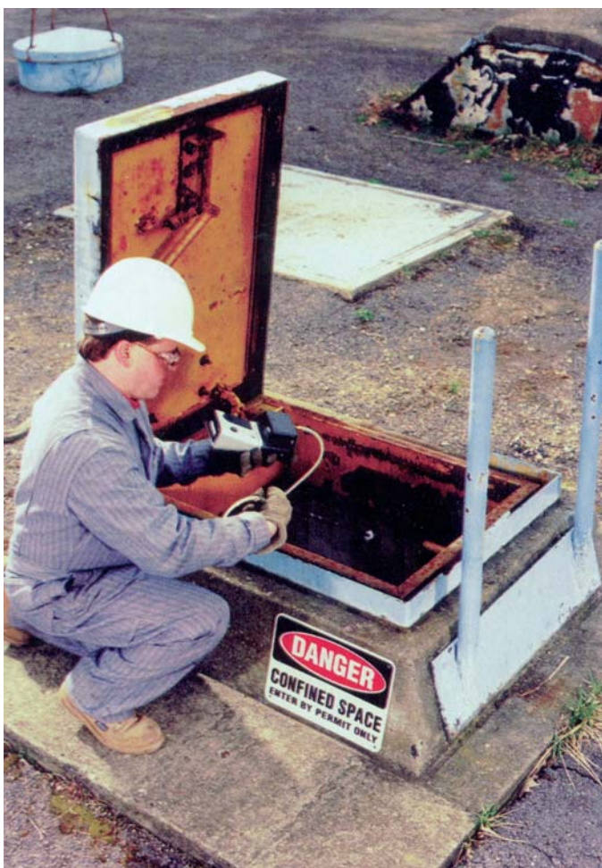
Εικόνα 29: Έλεγχος της ατμόσφαιρας του κλειστού χώρου με ειδικό εξοπλισμό, πριν την είσοδο σε αυτόν.
