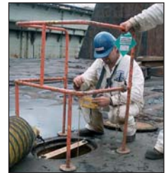
Εικόνα 14: Έλεγχος της ατμόσφαιρας πριν την είσοδο στον περιορισμένο χώρο.
