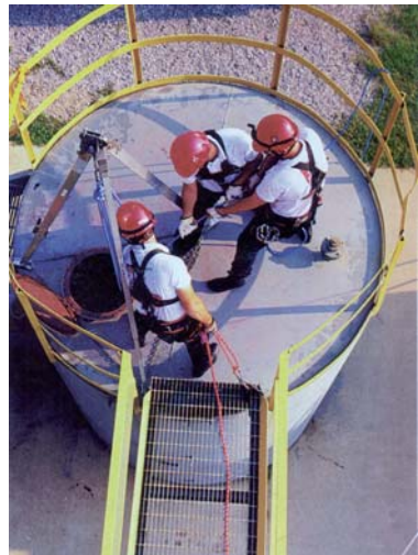
Εικόνα 33: Η ομάδα από τρία τουλάχιστον άτομα έχει τοποθετήσει τρίποδα πάνω από το άνοιγμα και προετοιμάζεται για είσοδο στη δεξαμενή. Όλοι φορούν ειδική εξάρτηση και είναι δεμένοι με «γραμμή ζωής» πριν την είσοδό του.
