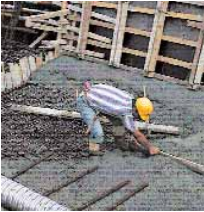
Εικ. 6. Σκυροδέτηση γέφυρας. Διάστρωση. Πηγή: 19.
