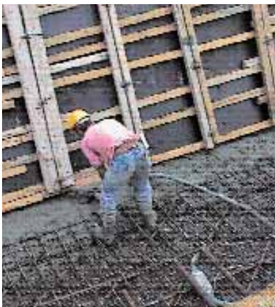
Εικ. 18. Σκυροδέτηση γέφυρας. Χρήση δονητών σκυροδέματος. Πηγή: 19
