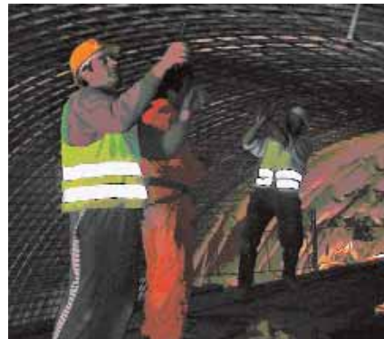
Εικ. 5. Τοποθέτηση οπλισμού σε σήραγγα. Πηγή: 19
