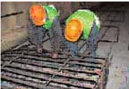
Εικ. 4. Τοποθέτηση οπλισμού σε σήραγγα: σιδέρωμα πεζοδρομίου. Πηγή: 19.
