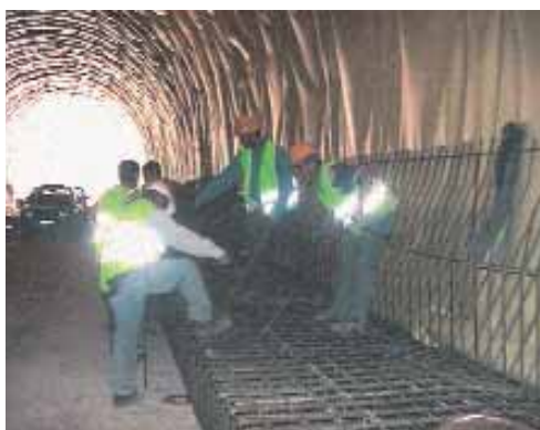
Εικ. 11. Τοποθέτηση οπλισμού με χρήση δικιάλας. Πηγή: 19.
