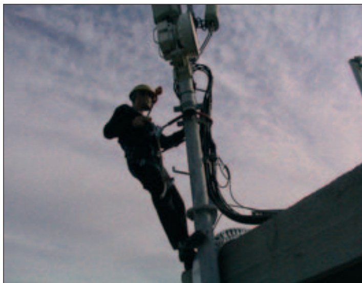
Εργασία σε στύλο με σύστημα συγκράτησης σε συνδυασμό με ολόσωμη ζώνη
