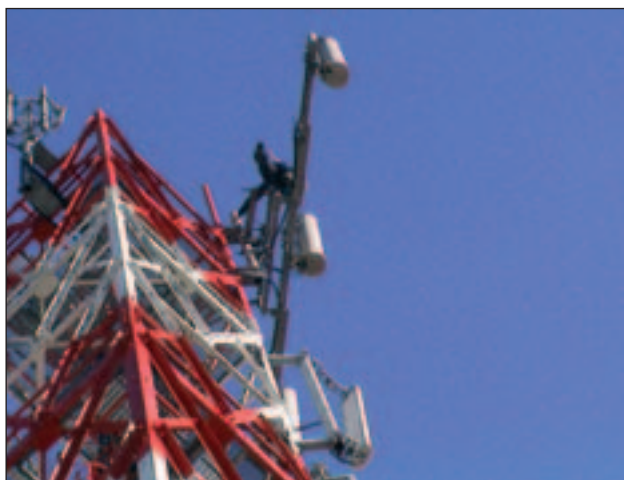
Εργασία σε εξωτερικές κεραιές με υψηλό κίνδυνο πτώσης
