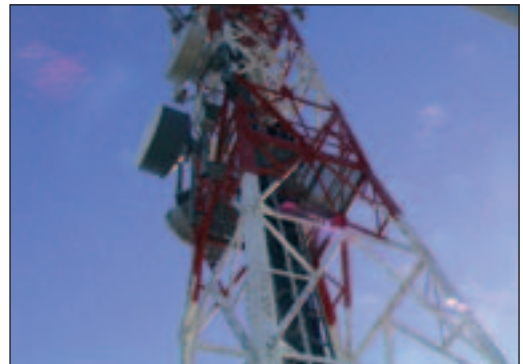
Πυλώνες με σκάλα με κιγκλιδώμα ασφαλείας και πατάρια
