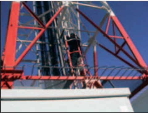
Πυλώνες με σκάλα με κιγκλιδώμα ασφαλείας και πατάρια
