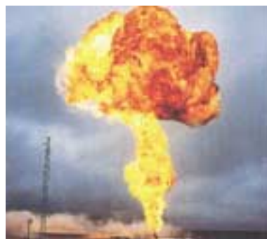
Φωτ. 6: Πύρινη σφαίρα από ανάφλεξη διαρροής σε αγωγό μεταφοράς υγροποιημένου προπανίου.
