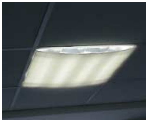
Φωτιστικό μέσα στο οπτικό πεδίο εργαζόμενου, καλυμένο από τον ίδιο για την αποφυγή θάμβωσης
