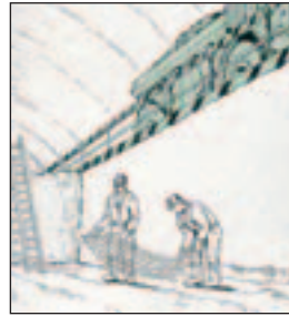
Εγκατάσταση προστατευτικού κιγκλιδώματος μεταξύ του χείλους της τάφρου και της οδού κυκλοφορίας του οχήματος 2
