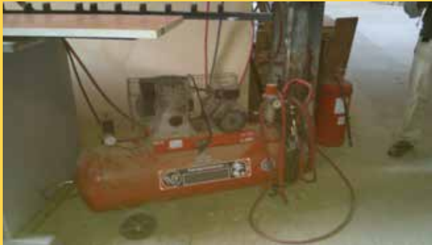
Αεροσυμπιεστής στον χώρο του ξυλουργείου
