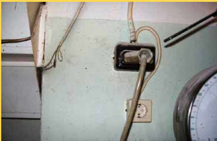
Ελλιπής συντήρηση καλωδίων
