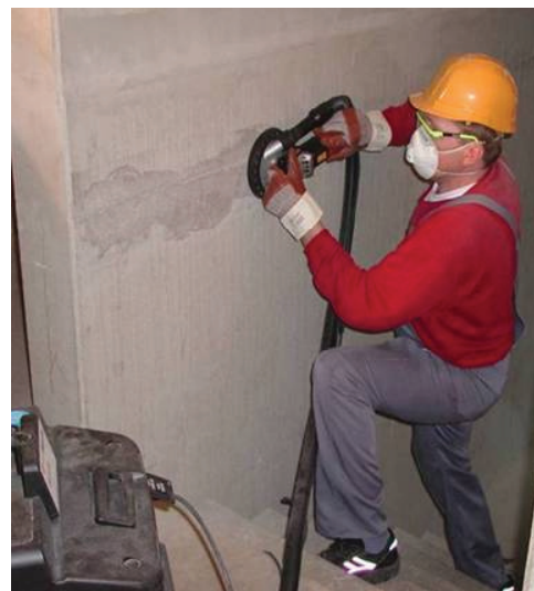
Λειαντικός τροχός χαμηλής παραγωγής σκόνης
