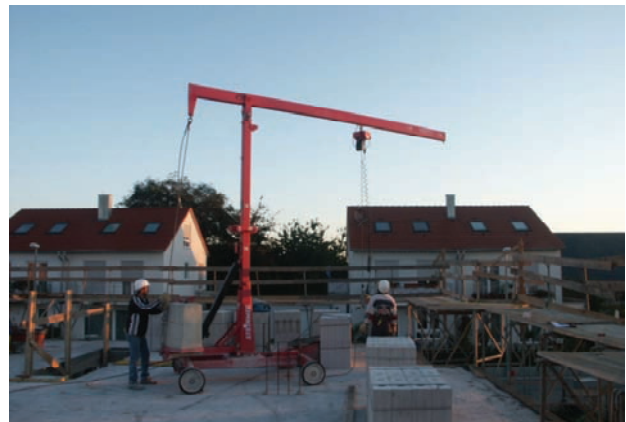
Μετακίνηση μεγάλων μπλοκ με μίνι-γερανό και ανυψωτικό κιβοπλίνθων
