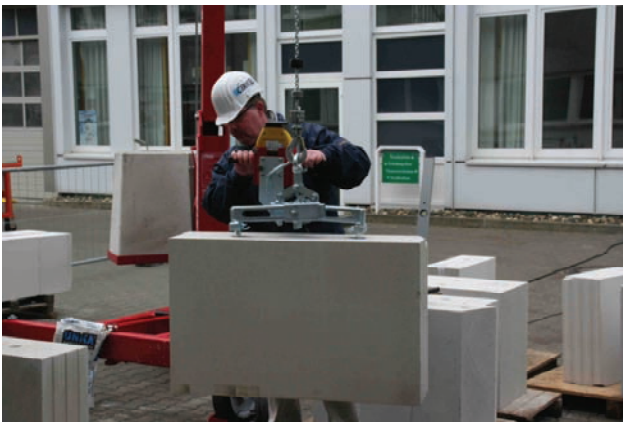
Μετακίνηση μεγάλων μπλοκ με μίνι-γερανό και ανυψωτικό κιβοπλίνθων
