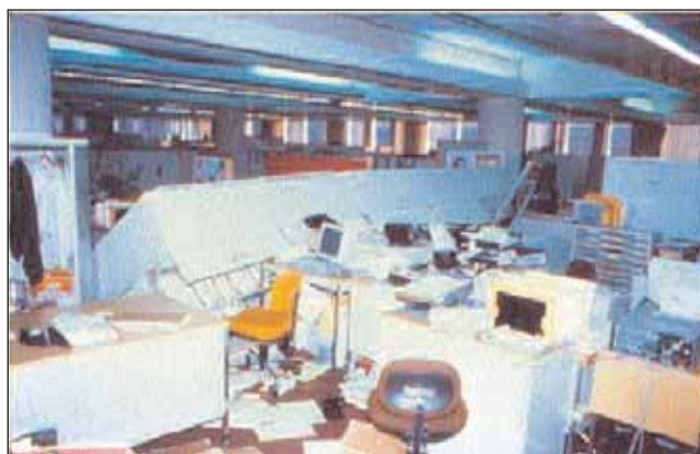
Σχήμα 39. Πτώση βιβλιοθήκης. Κίνδυνος τραυματισμού, αποκλεισμός διεξόδου.
