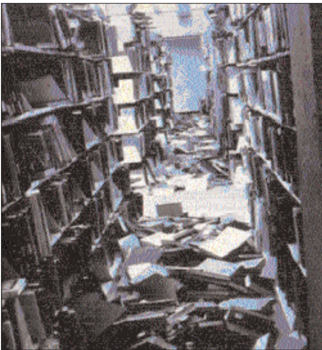
Σχήμα 6. Διασκορπισμός περιεχομένου ραφιών βιβλιοθηκών, παραμόρφωση βιβλιοθηκών που φράζουν διεξόδους. Πηγή: Guna Selvaduray, San Jose State University. Nonstructural Hazard Mitigation.
