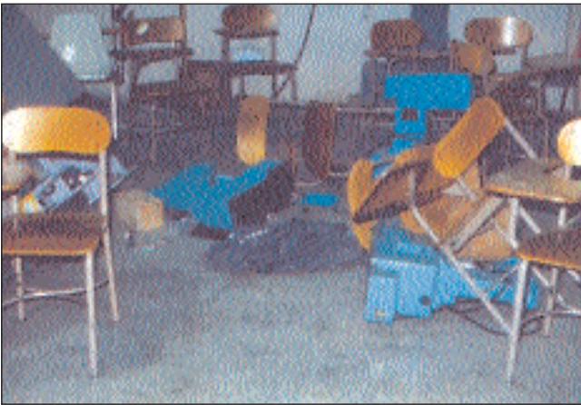
Σχήμα 4. Ανατροπή συσκευών μεγάλης αξίας λόγω ανεπαρκούς στερέωσης.
