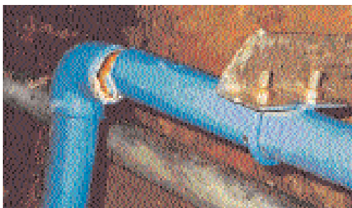
Σχήμα 5. 1. Η ανάρτηση του σωλήνα καταστράφηκε λόγω μη ύπαρξης διαγώνιων ενισχύσεων. Ο αεραγωγός της εικόνας καταστράφηκε λόγω πρόσκρουσης σε γειτονικό αγωγό. 2. Αγωγοί καλωδίων αποκολλήθηκαν από τις στηρίξεις τους στον τοίχο. Δεν υπήρχε ανάρτηση από την οροφή.
