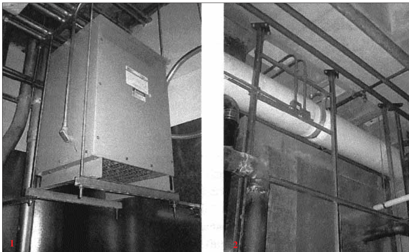
Σχήμα 14.1. Ανάρτηση μηχανολογικού εξοπλισμού.
