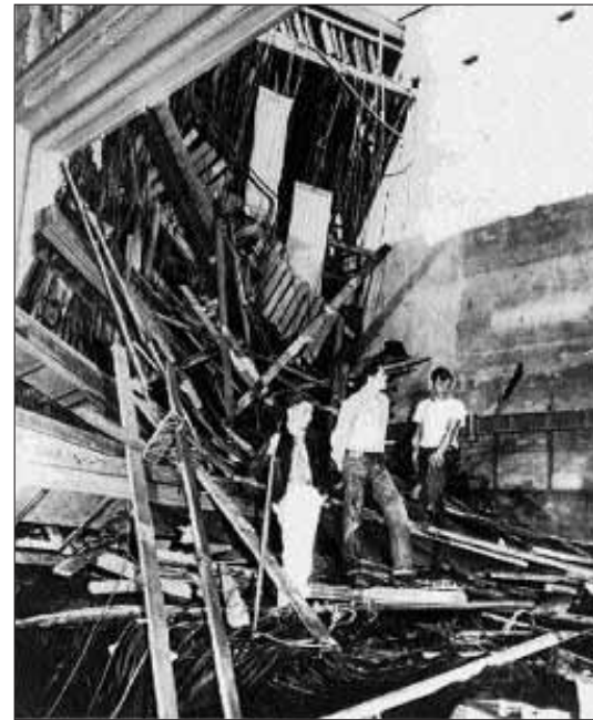
Σχήμα 4α. Ολική καταστροφή ψευδοροφής.
