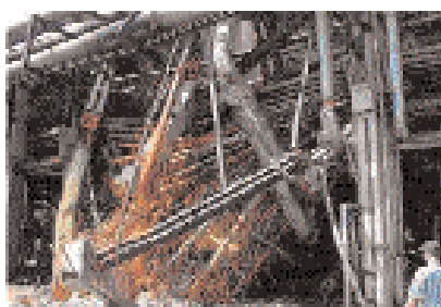
Σχήμα 1α. Πτώση σωληνώσεων πάνω σε αεραγωγούς, λόγω ανεπαρκούς αγκύρωσης. Κίνδυνος πρόκλησης πυρκαγιάς.
