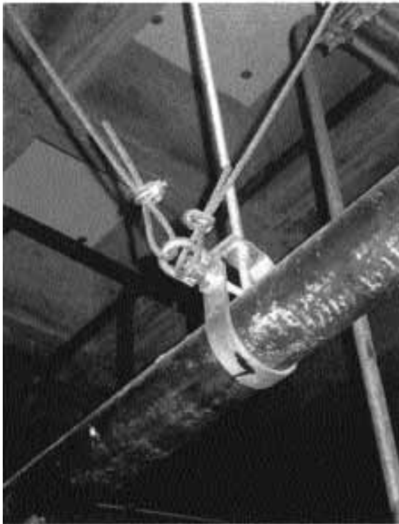
Σχήμα 8. Ενίσχυση με συρματόσχοινα.
