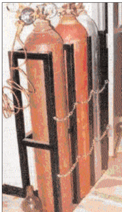
Σχήμα 68α. Διαμερισματοποίηση και ασφάλιση κυλίνδρων. Φωτ: G. Selvaduray.
