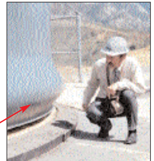
Σχήμα 4. Παραμόρφωση της μορφής «ποδιού ελέφαντα» σε κυλινδρική δεξαμενή. Πηγή: UCLA, California.
