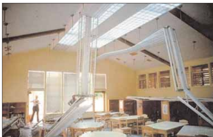
Σχήμα 1. Καταστροφή συνεχών γραμμικών φωτιστικών σωμάτων χωνευτών στην ψευδοροφή.
