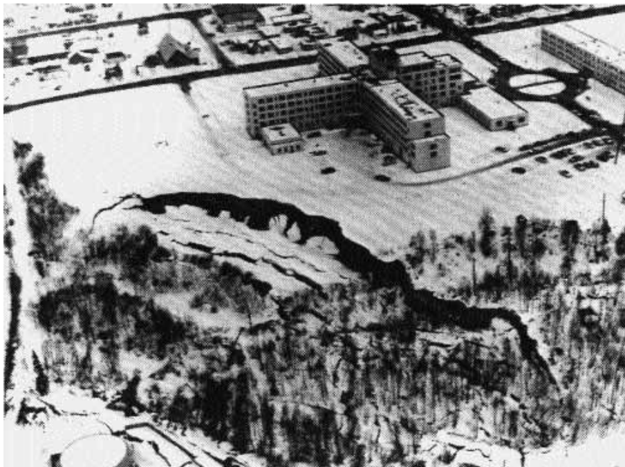
Σχήμα 3. Κατολίσθηση πρσανούς. Πηγή: Applied Technical Council (ATC) - 26 - 2.
