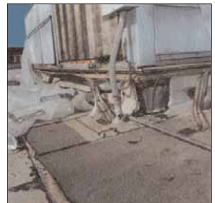
Σχήμα 2. Τυπική περίπτωση καταστροφής των στηρίξεων της βάσης.
