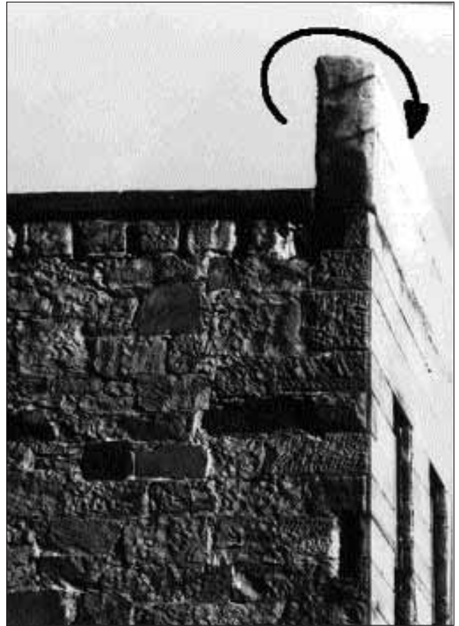
Σχήμα 1. Καταστροφή μη επαρκώς αγκυρωμένου στη- θαίου και διακοσμητικών διαζωμάτων.
