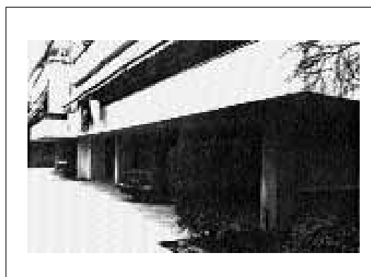
Σχήμα 30. Προσθήκη περιορισμένης έκτασης φερουσών διαζωματικών οπτοπλινθοδομών στην πιλοτή.
