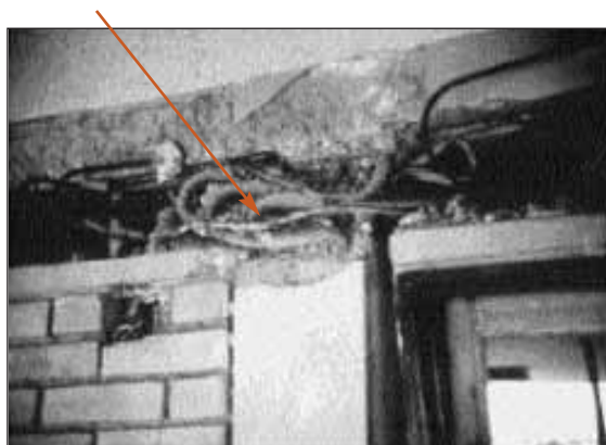
Σχήμα 20. Ζημιά σε υποστυλώμα λόγω του φαινομένου κοντού υποστυλώματος. Πηγή: PHO: Principles of disaster mitigation in Health Facilities.
