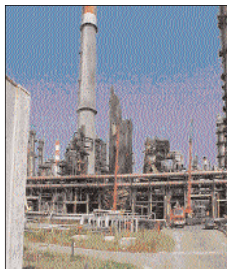
Σχήμα 5. Ελεύθερη καμινάδα μεγάλου ύψους σε εγκατάσταση πετροχημικών.
