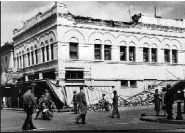
Σχήμα 1. Καταστροφή μη επαρκώς αγκυρωμένου στη- θαίου και διακοσμητικών διαζωμάτων.
