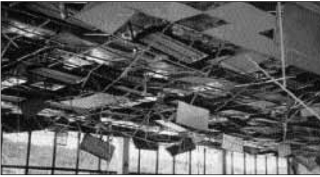
Σχήμα 2. Καταστροφή ψευδοροφής. Πηγή: Guna Selvaduray, San Jose State University. Nonstructural Hazard Mitigation.
