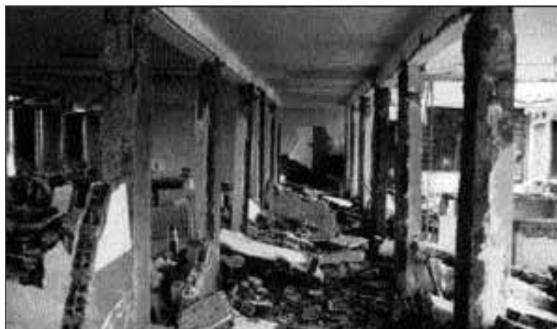
Σχήμα 4β. Καταστροφή τείχων πληρώσεως.
