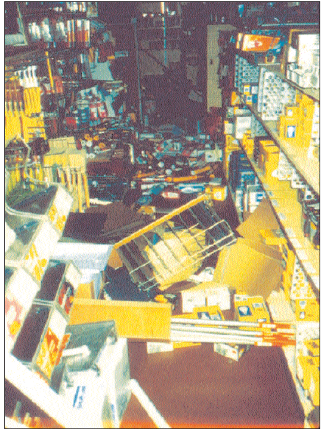
Σχήμα 5. Ανατροπή υλικών σε αποθηκευτικούς χώρους, λόγω ανεπαρκούς αντισεισμικής προστασίας των ραφιών και ακατάλληλου τρόπου τοποθέτησης των υλικών-προϊόντων. (Καταστροφή υλικών, κίνδυνος ανάφλεξης ή αντίδρασης, αποκλεισμός διεξόδου διαφυγής).
