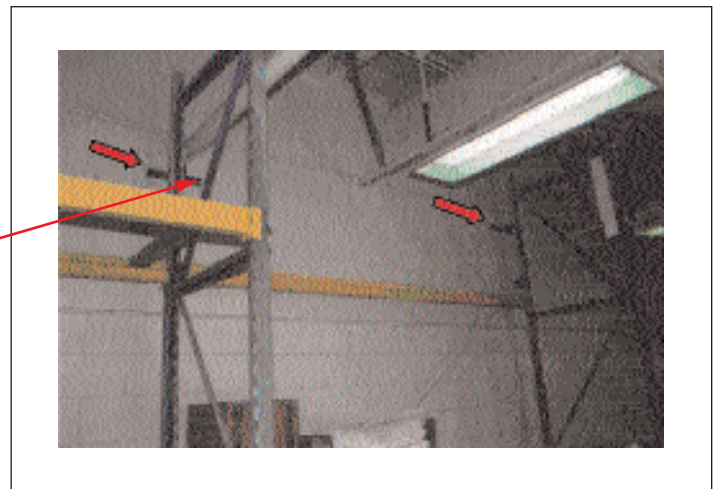
Σχήμα 64. Στήριξη ειδικών βαρέων εξοπλισμών σε σκελετό μεταλλικό, που διήκει από δάπεδο έως οροφή.
