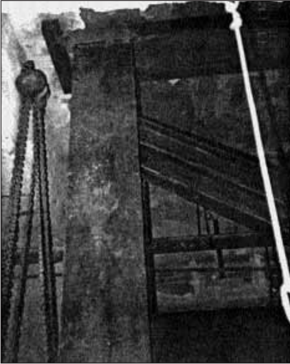
Σχήμα 31. Προσθήκη πλαισίου από χάλυβα στο ισόγειο κτηρίου με πιλοτή.
