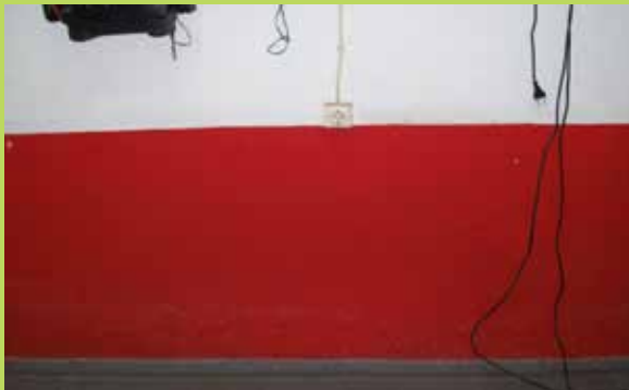
Εικόνα 7: Πρίζα μη στεγανού τύπου σε ακατάλληλο ύψος
