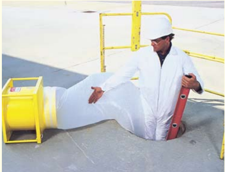
Εικόνα 3: Εισαγωγή αέρα με κατάλληλο εξοπλισμό ώστε να μην εμποδίζεται η ασφαλής πρόσβαση ή έξοδος τού εργαζόμενου.
