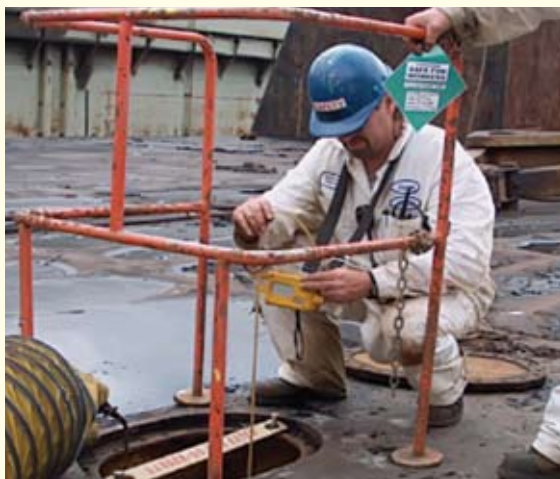
Εικόνα 2: Έλεγχος της ατμόσφαιρας πριν την είσοδο στον περιορισμένο χώρο.
