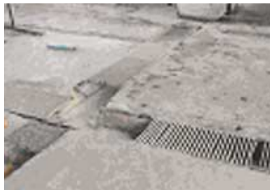
Σχήμα 2: Δάπεδο με ακατάλληλα καλύμματα καναλιών.
