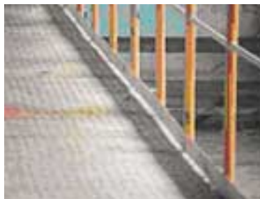
Σχήμα 11: Θωράκιο (σοβατεπί).
