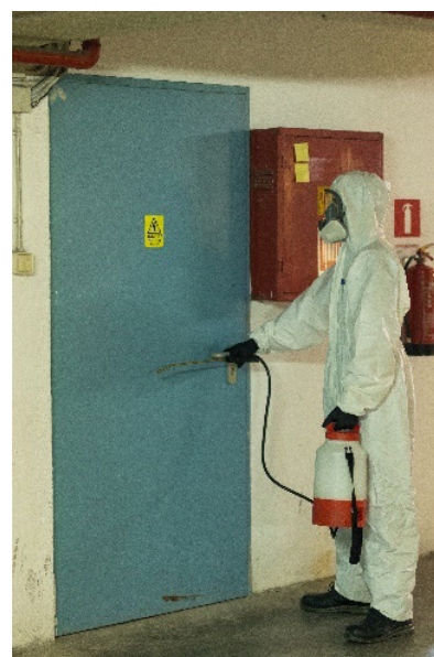
Εικόνα 1. Προειδοποίηση για είσοδο σε χώρο υψηλής τάσης
