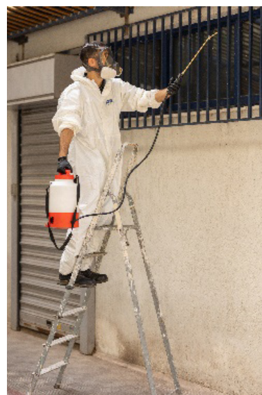
Εικόνα 2. Κίνδυνος πτώσης και έκθεσης σε χημικούς παράγοντες λόγω ακατάλληλου εξοπλισμού και εσφαλμένης χρήσης ΜΑΠ.
