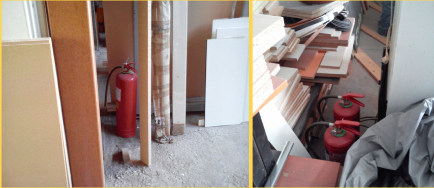
Πυροσβεστήρες χωρίς εύκολη πρόσβαση
