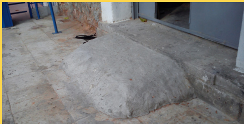
Ολισθηρό και απότομο σκαλοπάτι με κίνδυνο πτώσης σε σημείο όπου γίνεται μεταφορά βαριών φορτίων
