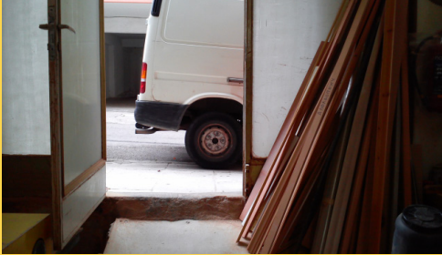
Αποθηκευμένα υλικά δίπλα στην έξοδο κινδύνου που μπορεί να την κλείσουν σε περίπτωση σεισμού
