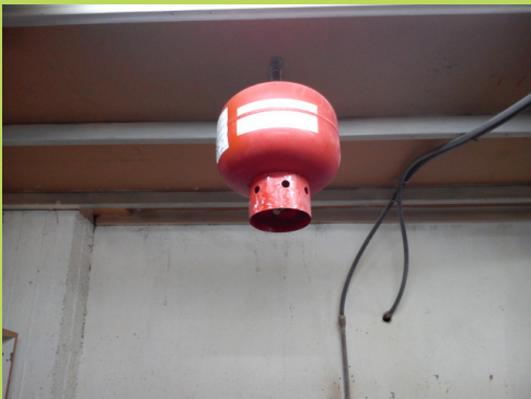
Πυροσβεστήρας οροφής
